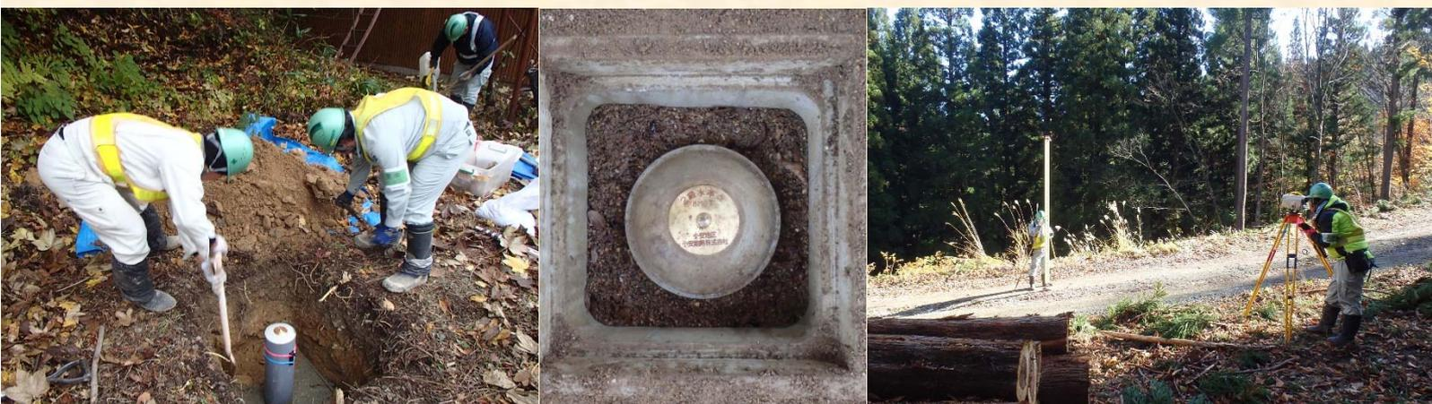
左／水準点設置の様子。中／水準点。右／林道での測量の様子。
